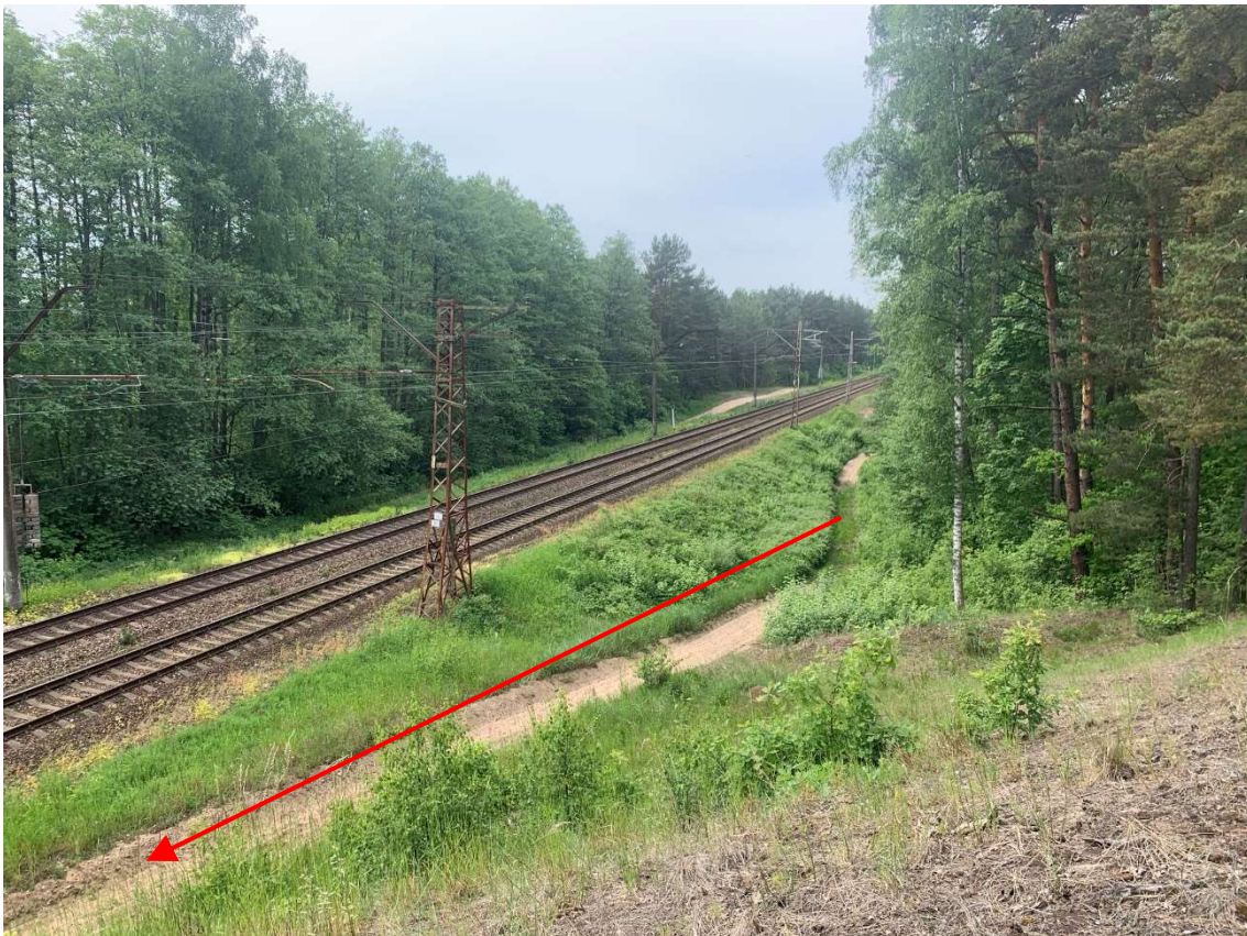
9.attēls. Dzelzceļa apkopes ceļš posmā no Kalngales dzelzceļa stacijas līdz Garciema dzelzceļa stacijai
