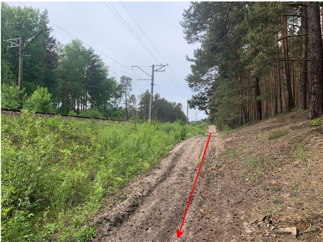
8.attēls. Dzelzceļa apkopes ceļš posmā no Kalngales dzelzceļa stacijas līdz Garciema dzelzceļa stacijai
