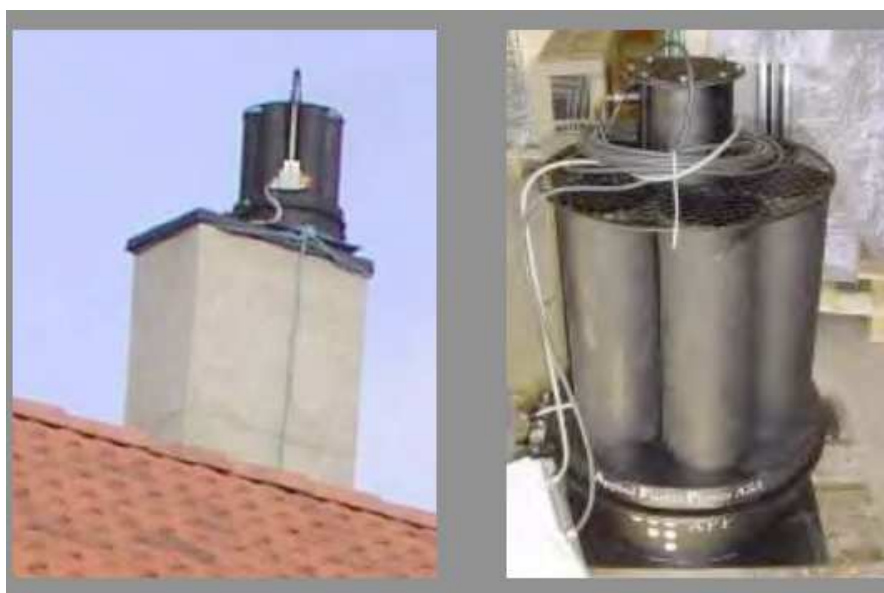
4. attēls. Elektrostatiskie daļiņu (PM) uztvērēji no dūmgāzēm kurināmās koksnes sadedzināšanas iekārtās 5kW - 100 kW [datu avots: 18].
