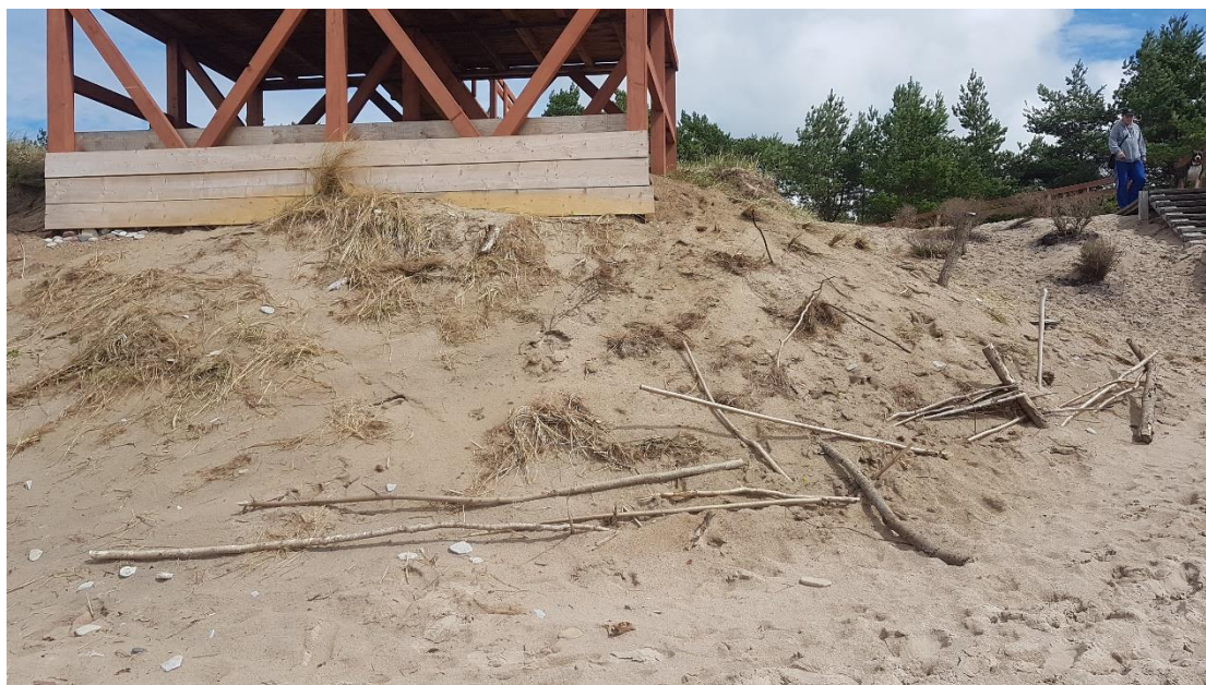
40. attēls. Īslaicīgi centieni aizkavēt jūras krasta erozijas procesus ar improvizētu zaru pinumu un neestētisku dēļu klājumu smilšu stabilizācijai zem izveidotās nojumes — skatu terases Medzes pagastā — vietā, kur notiek ļoti izteikta jūras krasta atkāpšanās.
